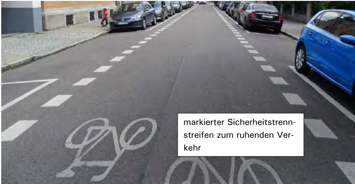
Abbildung 19: Markierter Sicherheitstrennstreifen zum ruhenden Verkehr und Bevorrechtigung Fahrradstraße an Knotenpunkten, Difu/BUW 2021, S. 26, S. 30, S. 33 /18/
